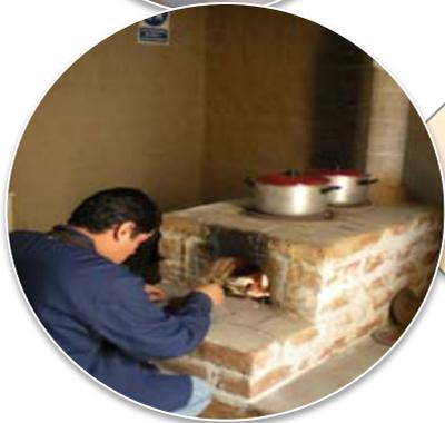
Cámara de combustión cerámica o albañilería recubierta con barro mejorado, estas ultimas presentan en el interior de los conductos el llamado "lomo de pescado". Parte de los modelos evaluados incluyen ceniceros internos o de parrilla.
