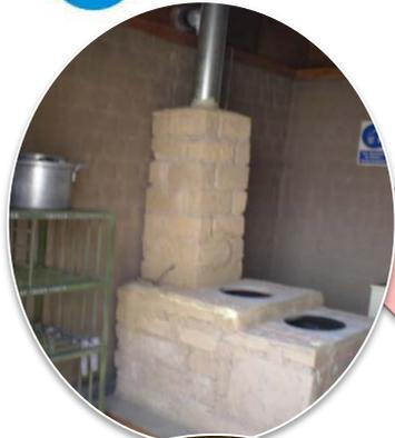
Cocinas a leña fija, con base de soporte de albañilería de adobe o ladrillo de arcilla.
